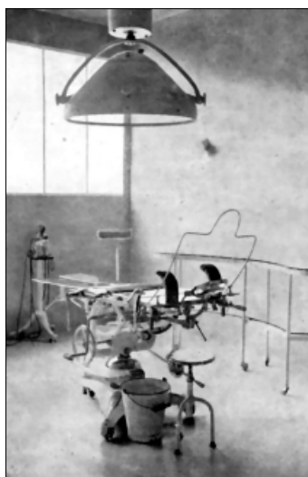
Foto 4. Primer quirófano de la Clínica.
